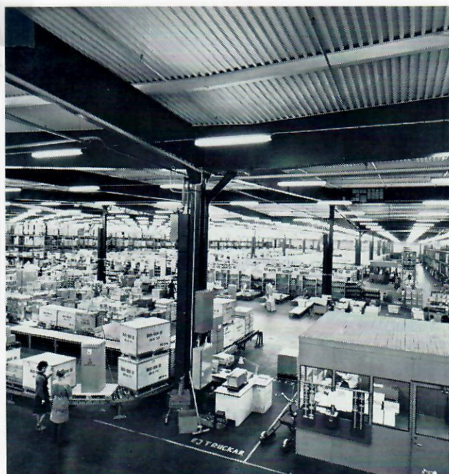
HSI-balken använd som primär- och sekundärtakstol för Ahlén & Holms Centrallager, Jordbro.
