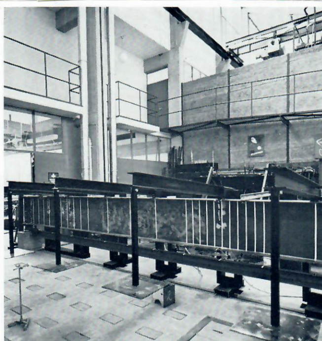
HSI-balk klar för provbelastning vid Tekniska Högskolan.
